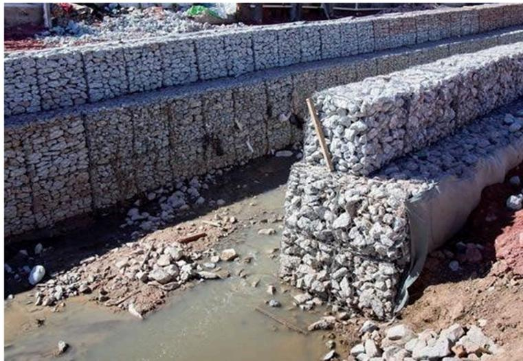
*Definição:* Trata-se de estruturas de arrimo tipo gravidade, flexíveis e permeáveis, constituídas por caixas de tela metálica em malha hexagonal de dupla torção, preenchidas por pedra de mão ou britadas, cujo diâmetro deve estar entre uma vez e meia a duas vezes e meia a máxima abertura da malha. Estas caixas, em forma de prismas retangulares, com variação de dimensão igual a 0,5 m, devem ser montadas nos locais designados para as
